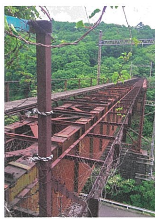
旧立場川橋梁
